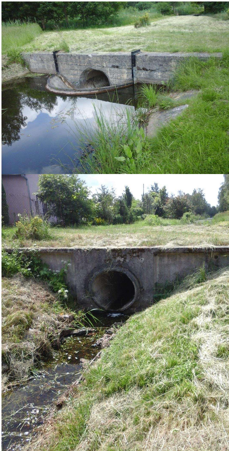
28 pav. Hidrotechninis įrenginys vandens lygio pakėlimui Rėkyvos ežero šiaurinėje dalyje
